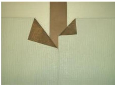
Legen Sie das trockene Kupfervlies in das Kleberbett ein und drücken Sie es gut an. Stellen Sie sicher, dass sich ein Abdeckstreifen unter jeder Naht befindet.
