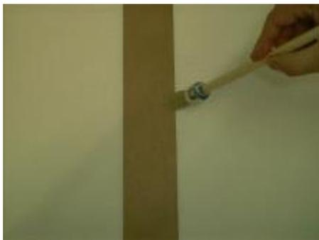
Verkleben Sie unter jeder horizontalen und vertikalen Naht einen Abdeckstreifen, Art. Nr. 9070033 mit der Kupferseite nach oben (sichtbar). Tragen Sie Klebstoff auf der Oberseite des Abdeckstreifens auf.
