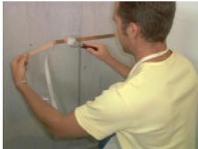
**5. Für den Erdungsanschluss kleben Sie nach ausreichender Trocknung ein Kupferband (Art.-Nr. 97406) auf die Oberfläche und verbinden das Band mit einem geeigneten Erdungsanschluss. Eine im Raum ringförmig umlaufende Verwendung des Kupferbandes wird empfohlen.**
